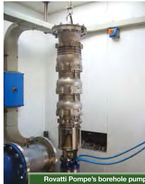
Rovatti Pompe's borehole pump
