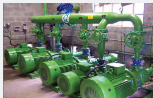
Installazione elettropompe monoblocco multistadio
